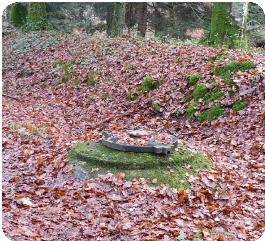
Captage d'eau souterraine de la forêt de Fougères (Ille et Vilaine) – Photo ARS Bretagne.
