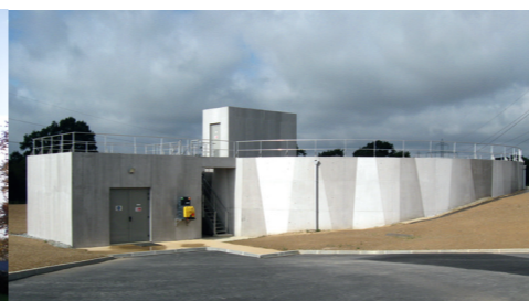
Reservoir des Onzes Journaux : 2x1000 m 3 Reservoir d'Erceé-Près-Liffré : 2x3000 m 3
